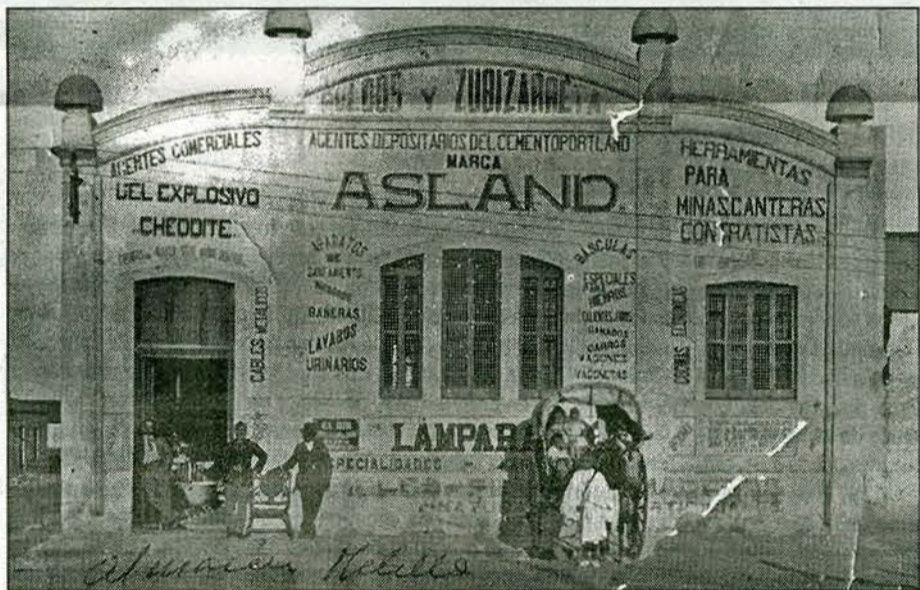
Distintas instantáneas de lo que era antes y lo que es hoy el edificio emblemático del barrio del Industrial
